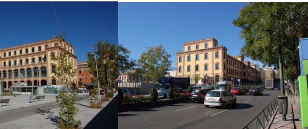
Estado después de la restauración
