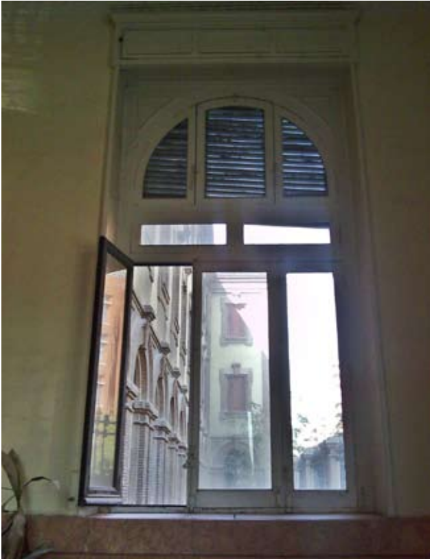
Estado inicial de los ventanales antes y tras su sustitución. La españoleta por cara ha sido sustituido por una falleba por canto
