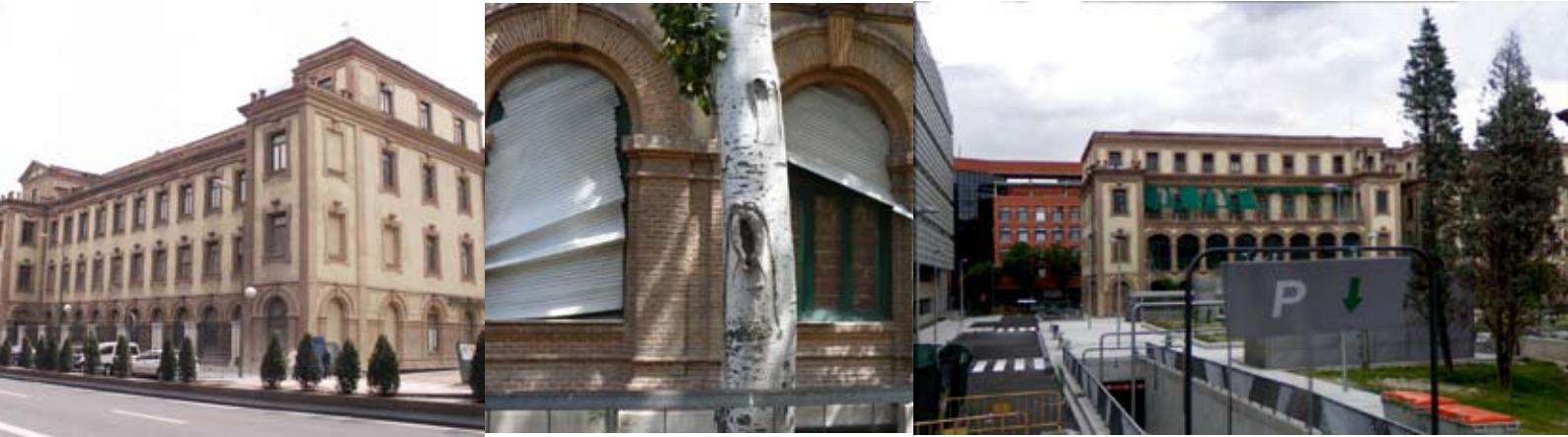
Estado previo del edificio
