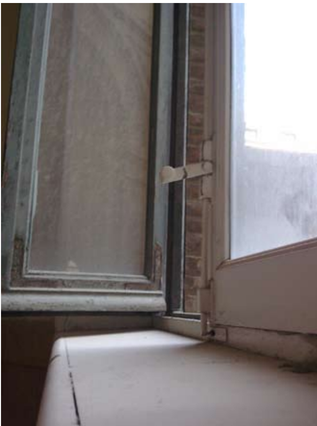
Estado inicial de los ventanales antes y tras su sustitución. La españoleta por cara ha sido sustituido por una falleba por canto
