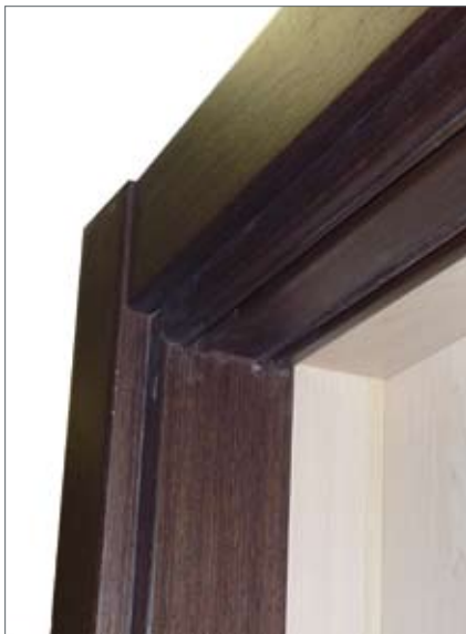
DETALLE DE GUIA SUPERIOR EN ARMARIOS CORREDERA.
