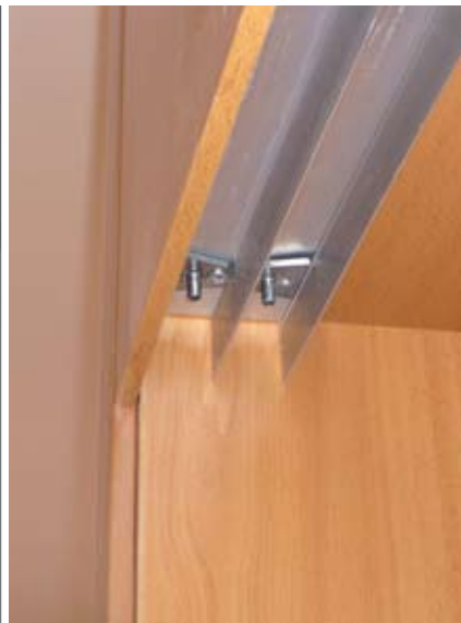
DETALLE DE GUIA SUPERIOR EN ARMARIOS CORREDERA OMEGA.
