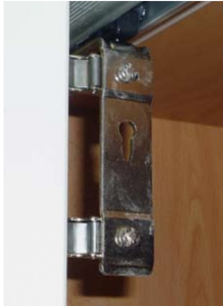
DETALLE DE HERRAJE SUPERIOR DE ARMARIO PLEGABLE.
